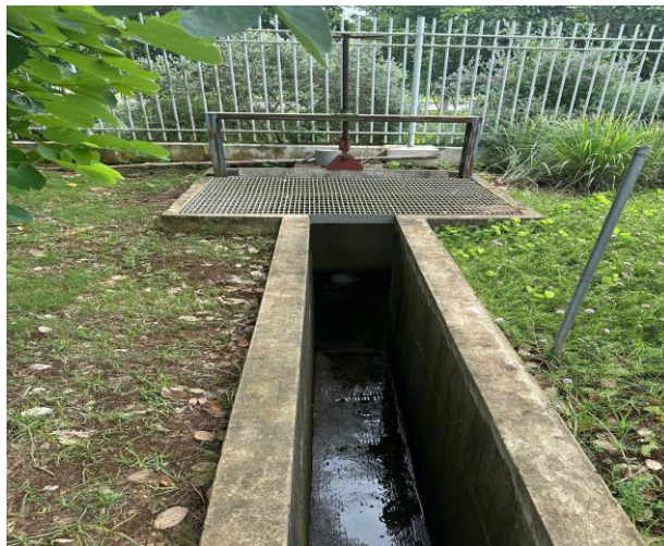
Hình 3.3. Cửa xả số 1 và số 2 thoát nước mưa của cơ sở
