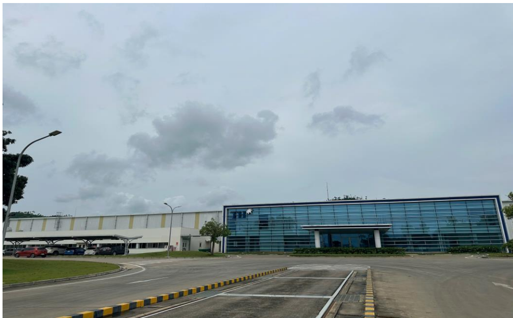
Hình 3.16. Bê tông hóa các tuyến đường nội bộ tại nhà máy
