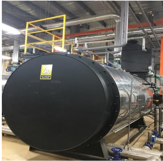
Hình 3.15. Hình ảnh nồi hơi được lắp đặt và vận hành tại Nhà máy
