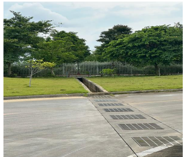
Hình 3.3. Cửa xả số 1 và số 2 thoát nước mưa của cơ sở
